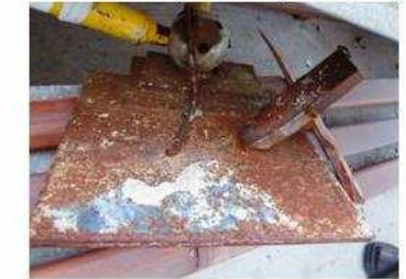
Levha üstüne levha, üstüne levha, küre kolon dışında
