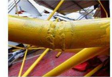
Çok kısa boru parçaları uç uca kaynatılmış
